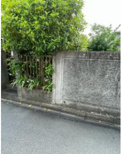
北側境界付近
